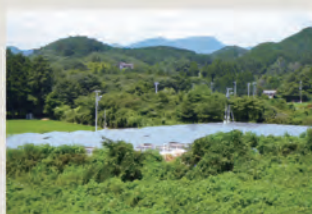
■ 日光市手岡発電所
