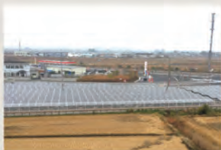
■ 太田市龍舞町発電所
