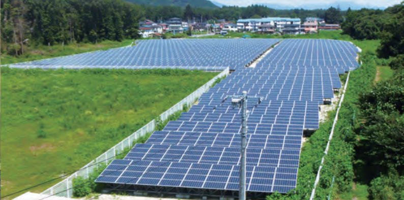
■ 日光市明神発電所
