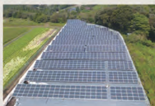
■ 渋川市赤城山発電所
