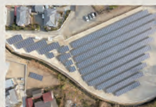
■ 太田市只上町第2発電所
