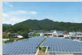
■ 鹿沼市見野発電所
